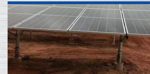
Estruturas metálicas alumínio e aço carbono Galvanizado.
